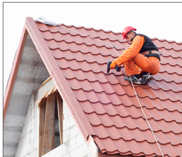
Figura 5. Trabajos sobre planos inclinados.
