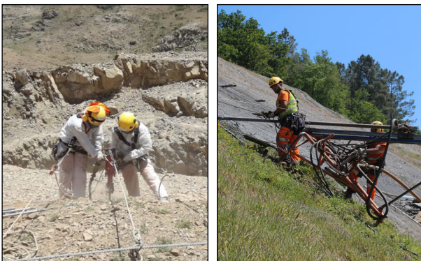
Figura 7. Trabajos realizados en taludes utilizando sistemas de sujeción. Fotografías propiedad de Desnivel Agranaltura, S.A.
